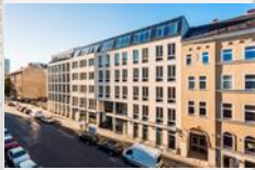
Geschäftshaus Bernburger Straße 30/31
