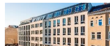
4 Geschäftshaus Bernburger Straße 30/31
