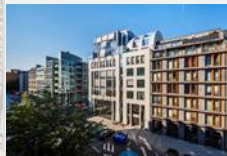
Wohn- und Geschäftshaus Charlottenstraße 79/80
