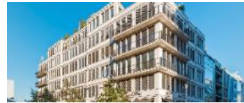
3 Wohn- und Geschäftshaus Jägerstraße 34/35
