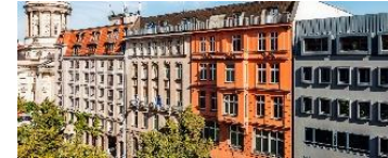
2 Wohn- und Geschäftshaus Jägerstraße 54/55
