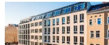
4 Geschäftshaus Bernburger Straße 30/31
